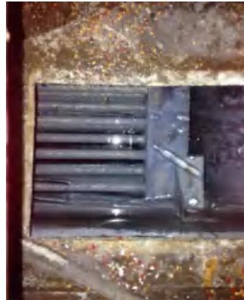
图10 释冷结束后蓄冰槽内浮冰
