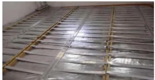
(b) 微热管阵列与扁水管的布置(未填充混凝土)
